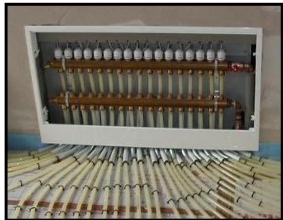
Heizkreisverteiler
